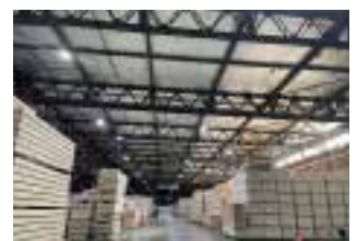
施工完了状況
