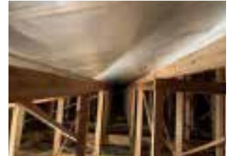
天井裏に施工! 空調の効果向上!
